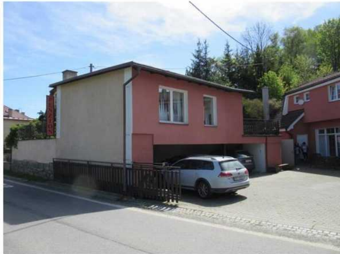
Pohled na vedlejší stavbu od severozápadu
